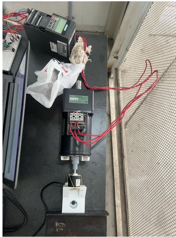
Figura 10. Conexión del MM440 con el motor de inducción trifásico BHI62S-15.
