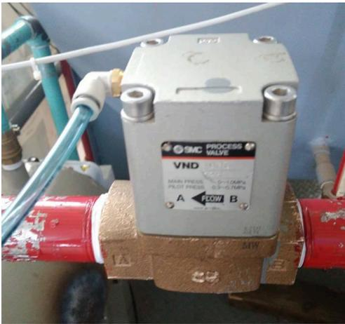
IMAGEN 4 a) Válvula pilotada
