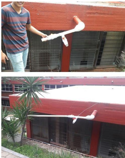
**IMAGEN 3:** Instalación del captador de agua de lluvia
