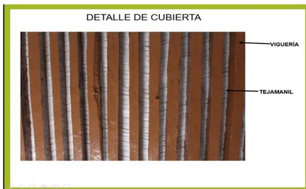
IMAGEN 7: Detalle de Cubierta, Equipo Verano 2017.
