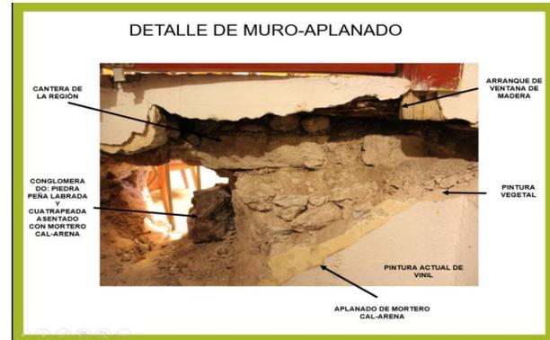
IMAGEN 4: Detalle de Muro, Equipo Verano 2017
