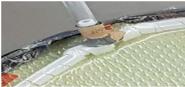
IMAGEN 3: Conexión y sellado de las mangueras
